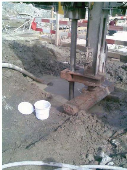
Abb. 1-1: Probenahmestelle Bohrlochmund<sup>[11]</sup>
