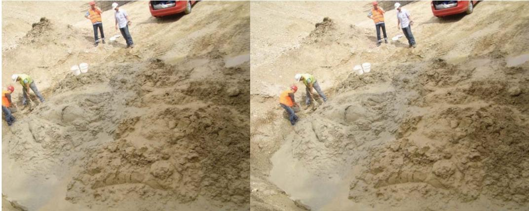
Abb.5.: Probenahme aus dem Bohrfahlaustrag.
