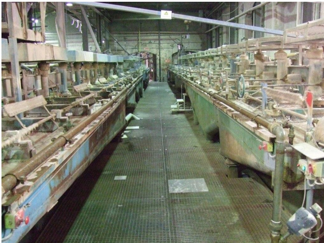
Abbildung 7: Flotationsanlage in Wolfach
