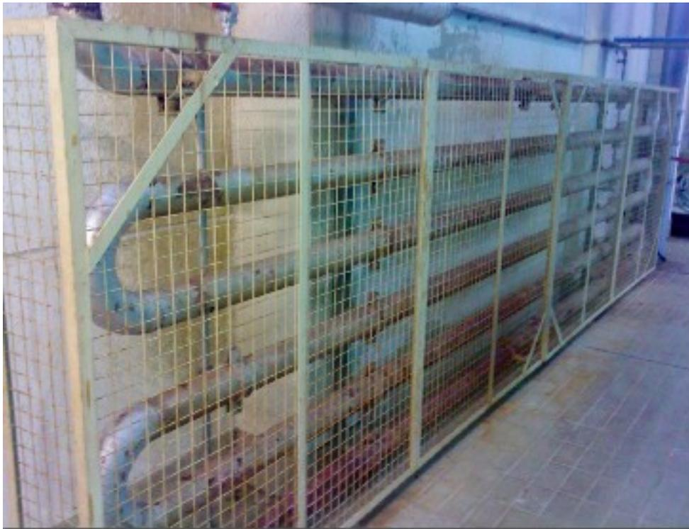
Abbildung 6: Die Wärmeabgabe in der Kläranlage erfolgt durch ungedämmte Rohre
