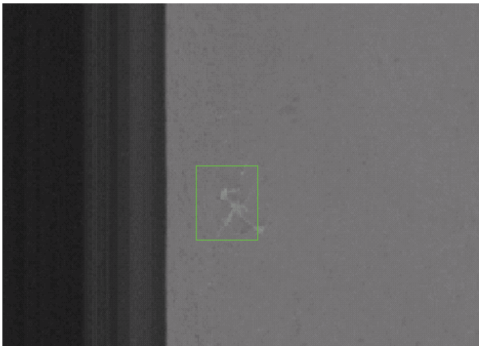
Bild 44: Netzförmiger Kantenquerriss, Bild aufgenommen mittels SIAS, Stahlgruppe 1
