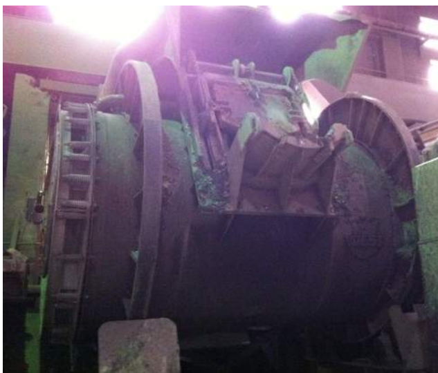
Abbildung 4.1: Konverter der Montanwerke Brixlegg
