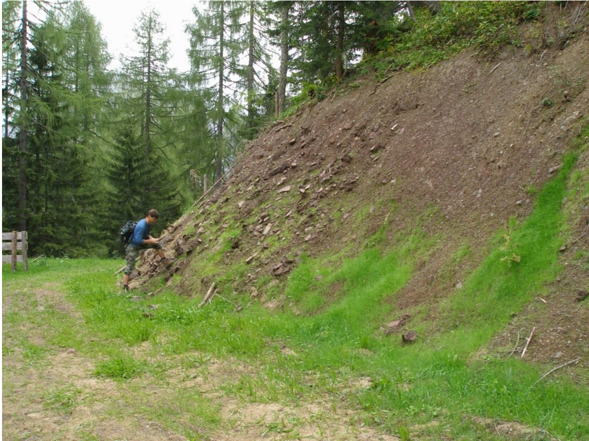
Abb. 42: Verrutschte Radiolarite an der Nordseite des Wurzerkampls
