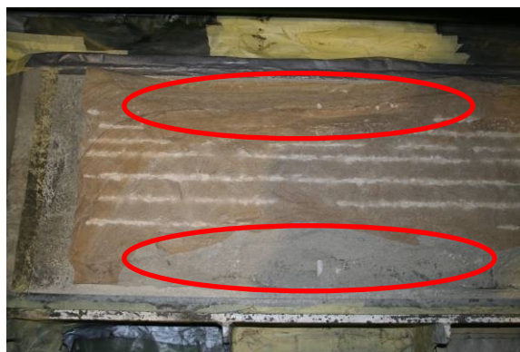
Abbildung 35: Abbruch der rechten und linken Kante
