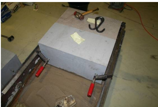
Abbildung 26: Einbau der 60-iger-Blöcke mit Schraubzwingeneinsatz
