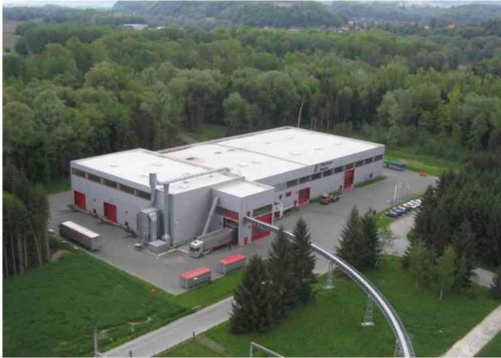
Abbildung 12: Luftaufnahme des Thermo Team-Betriebsgelände in Retznei
