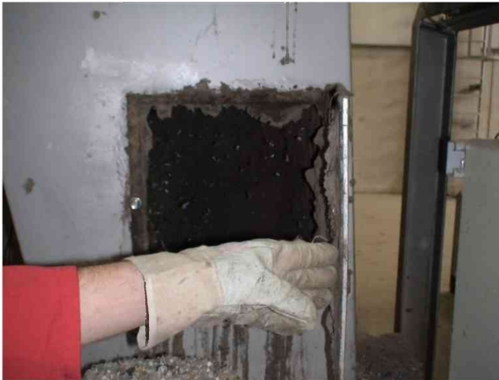
Abbildung 34: Probenahmestelle vor dem Austrag in das ASB-Outputlager
