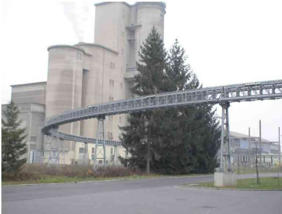
Abbildung 25: Rohrbandförderer zur Belieferung des Zementwerkes
