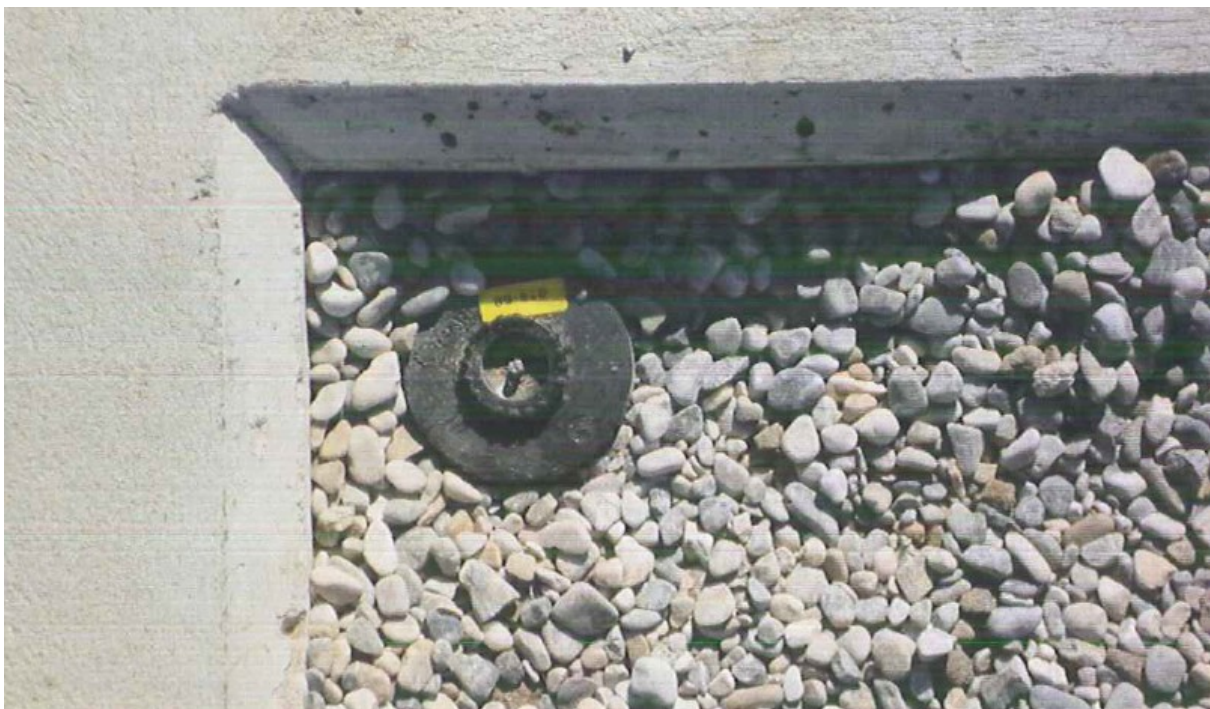
Abbildung 18: Bewässerungsanlage bei Sandbunker 2.
