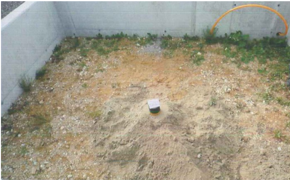
Abbildung 16: Sandbettung um die Gasaustrittsstellen.
