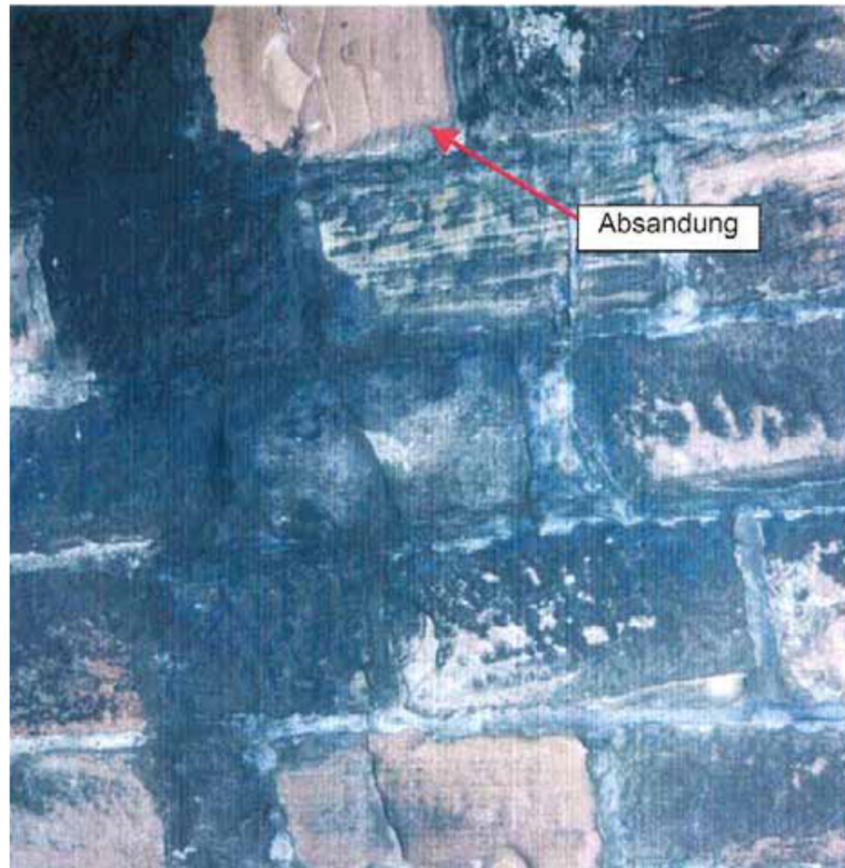
Abbildung 24 - Beispiel für Absandung 42
