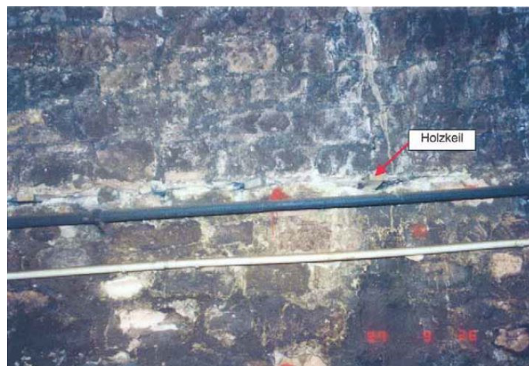
Abbildung 28 - Beispiel für Längsriss 51
