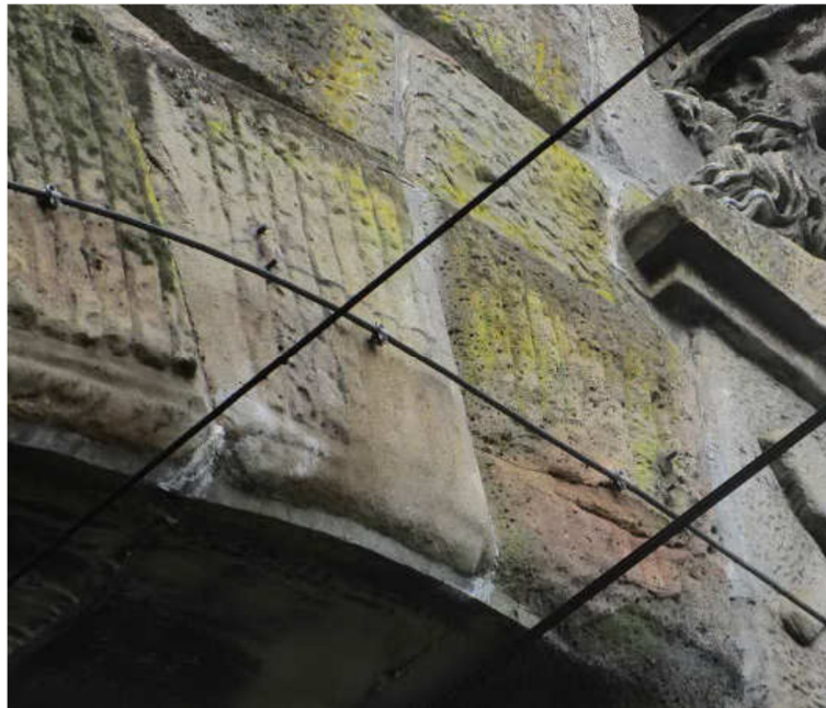
Abbildung 23 - Beispiel für Winderosion 43
