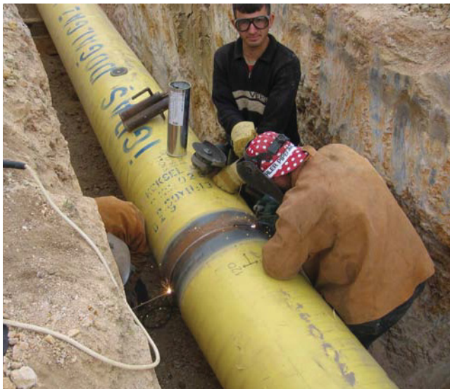
Abb. 2-2: Wurzelschweißung mittels zwei Schweißern inklusive einem Helfer im Rohrgraben
