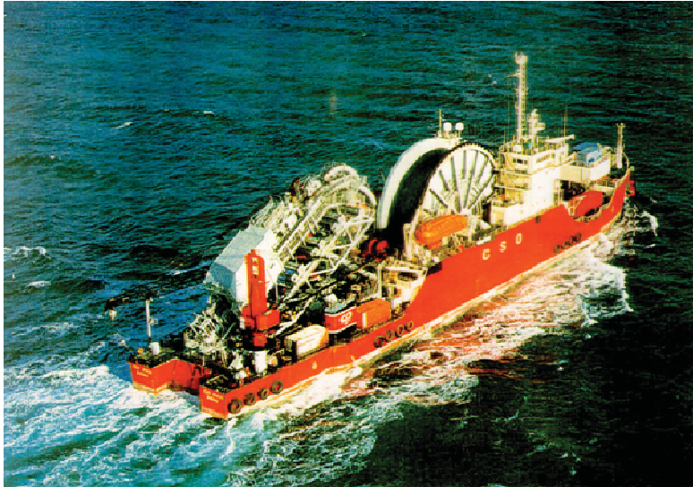
Abb. 2-4: Reel barge zur Verlegung von Pipelines bis 24“ Durchmesser im Wasser
