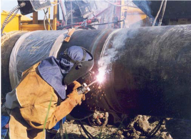
Abb. 2-18: Schweißen einer Fülllage mit selbstschützenden Fülldrähten in 3- Uhr- Position
