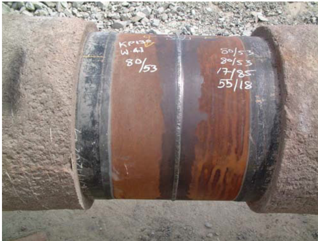
Abb. 2-3: Fertiggestellte Verbindungsnaht vor Aufbringung des passiven Korrosionsschutzes.
