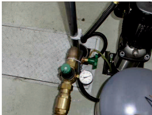
Abbildung 2: Hauptwasserzufuhr. Grünes Rad zu Beginn voll aufdrehen.
