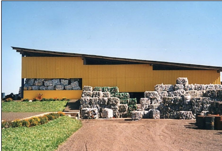
Abbildung A.1: Abfallbehandlungsanlage von Estrela
