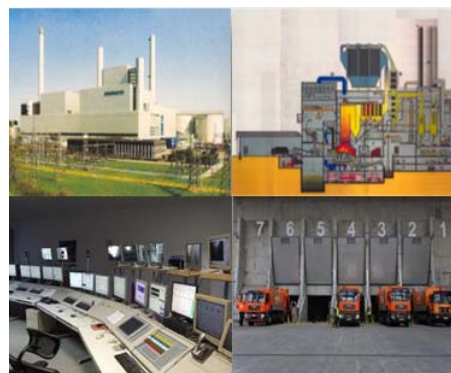
Slika 1. Prikaz savremene spalionice za opasan otpad sa automatizovanim komandno - kontrolnim centrom
