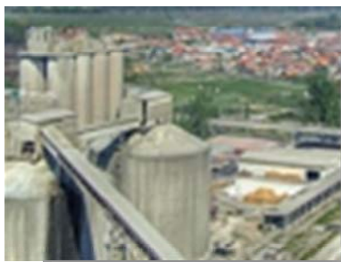
Slika 3. Prikaz cementare koja kao gorivno sredstvo koristi mešoviti otpad sa lokacijom u području najužeg gradskog okruženja u R. Srbiji
